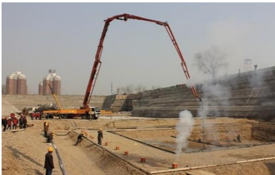
图 1. 建筑工程施工现场
